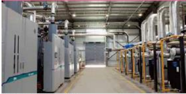
LPG Boilers (Mongolia)/ Saisan Co., Ltd.
